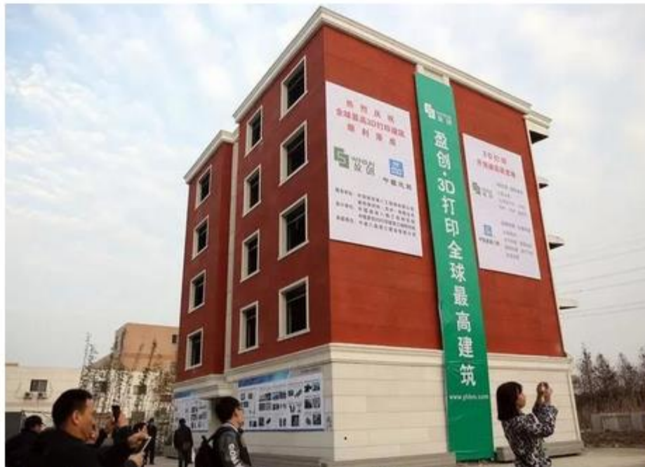
Empresa chinesa constrói primeiro edifício do mundo com uma impressora 3D (Foto: Reprodução/Cnet)
